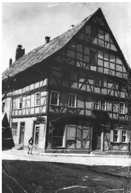
Wohn- und Geschäftshaus der Familie Katzenstein in Volkmarsen, Baustraße/Ecke Steinweg. Julius Wertheim war Angestellter im Textilgeschäft Katzenstein.
