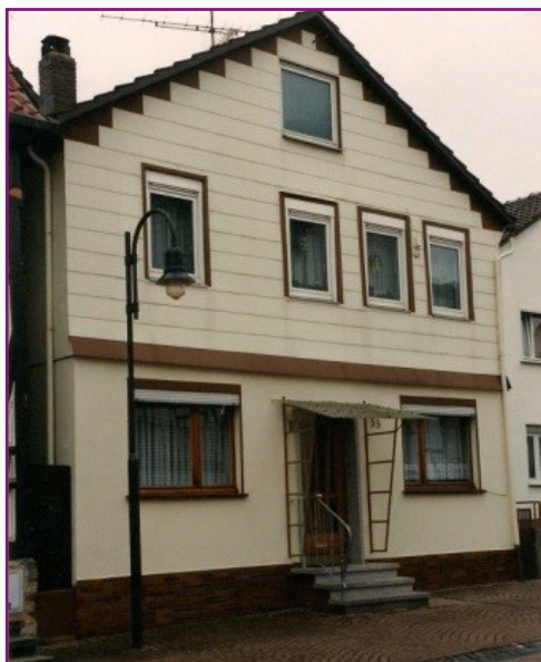
Ehem. Wohnhaus der Fam. Lichtenstein, Obere Stadtmauer 33, Volkmarsen
