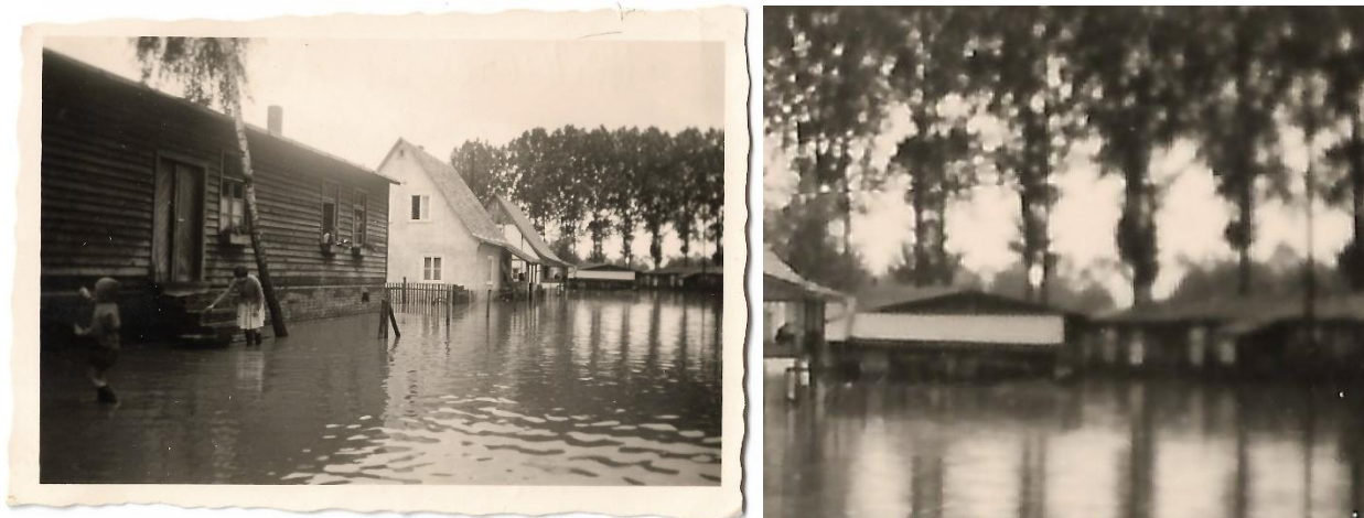
Die noch verbliebenen Gefangenen-Baracken (Aufnahme 1956 bei Überflutung durch Hochwasser)
